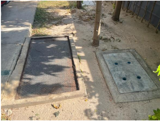
รูปที่ 3-20 บ่อหน่วงน้ำและบ่อพักน้ำ
