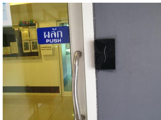
รูปที่ 3-41 ติดตั้งระบบ access control ด้วยระบบ keycard บริเวณประตู ทางเข้า-ออกอาคาร
